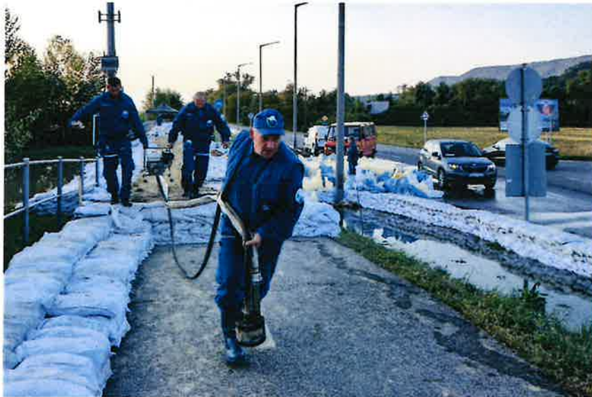
2. FÉNYKÉP. MOBILSZIVATTYÚT TELEPÍTENEK A FETIVIZIG DOLGOZÓI DUNABOGDÁNYBAN, 2024 SZEPTEMBERÉBEN
