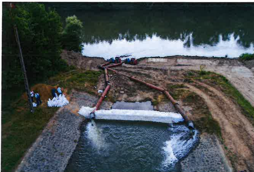
7. FÉNYKÉP. TISZÁBÓL TÖRTÉNŐ MOBILSZIVATTYÚS VÍZPÓTLÁS A BEREGBEN, 2025 JÚNIUSÁBAN
